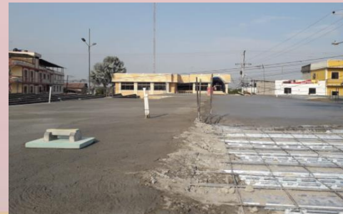
ENLUCIDA DE LOSA
