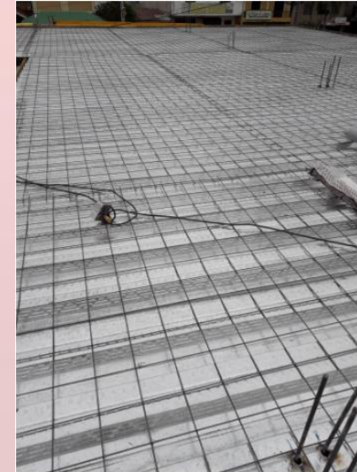
COLOCACION DE MALLA
