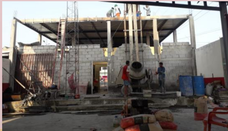
FUNDICION DE LOSA
