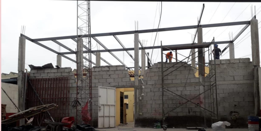
COLOCACION DE ESTRUCTURA METALICA
