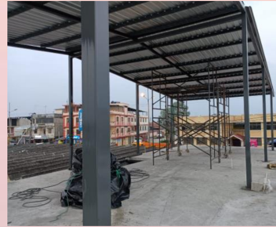
COLOCACION DE TECHADO
