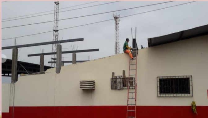
DESMONTAJE DE CUBIERTA DE TECHO
