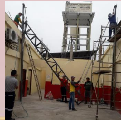
INSTALACION DE CERCHAS
