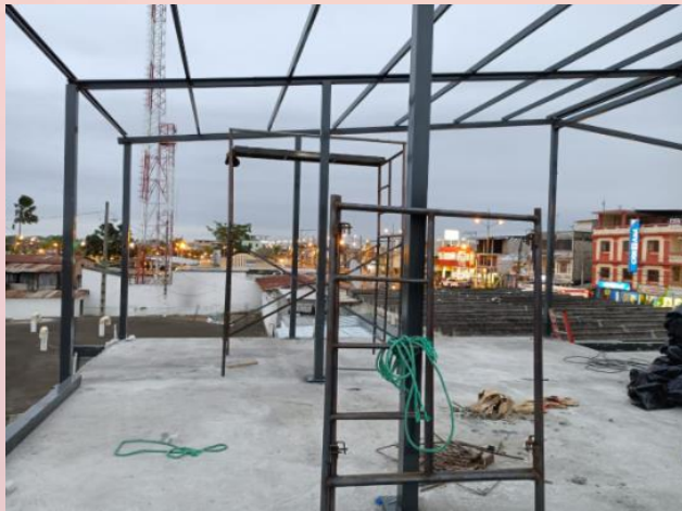
COLOCACION DE ESTRUCTURA METALICA
