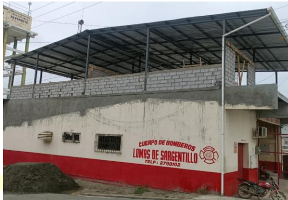
CERRAMIENTO CON BLOQUE
