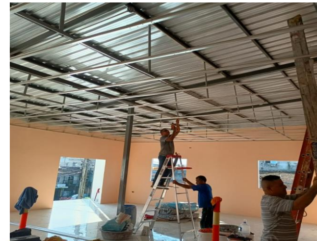
INSTALACION DE SISTEMA ELECTRICO Y DETECTOR DE HUMO
