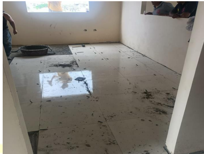
INSTALACION DE PISO DE CERAMICA
