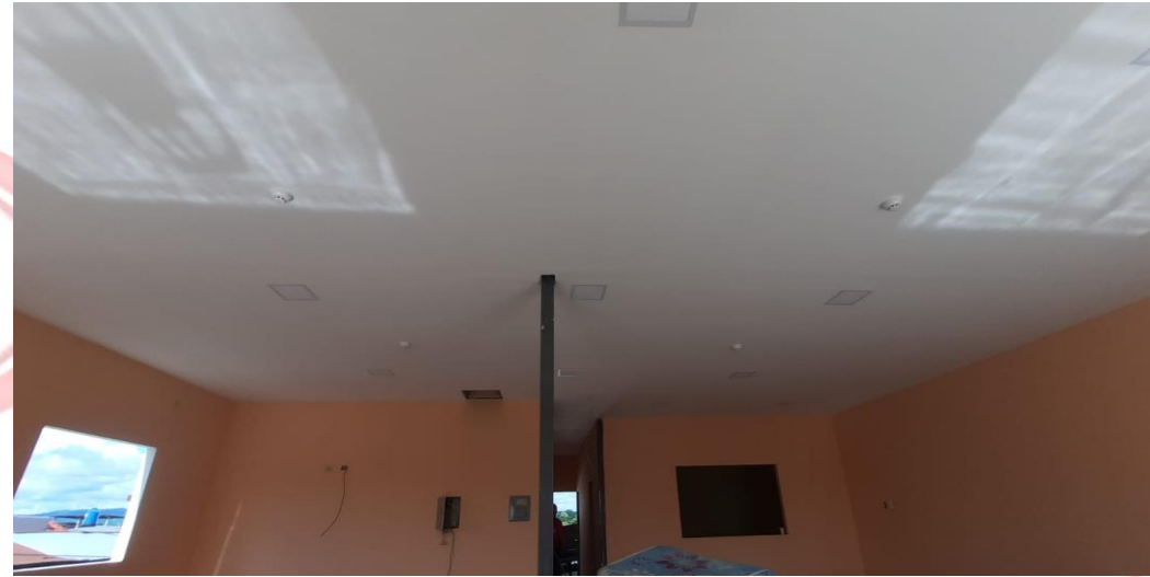
INSTALACION DE LUCES Y DETECTORES DE HUMO
