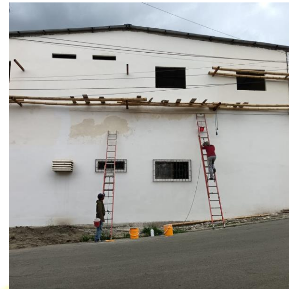
EMPASTE EXTERIOR PLANTA ALTA Y PLANTA BAJA
