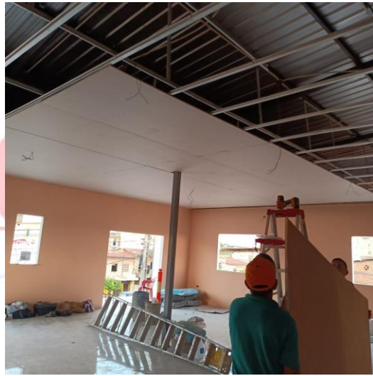
COLOCACION DE GYPSUM LISO
